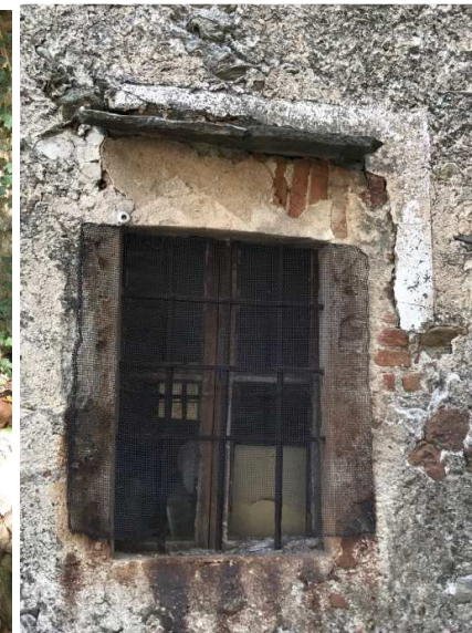
Figura 50: architrave in conci di mattoni
