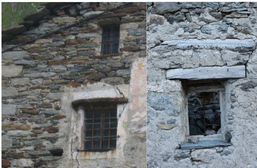
Figura 40: architrave in pietra e cornice intonacata
