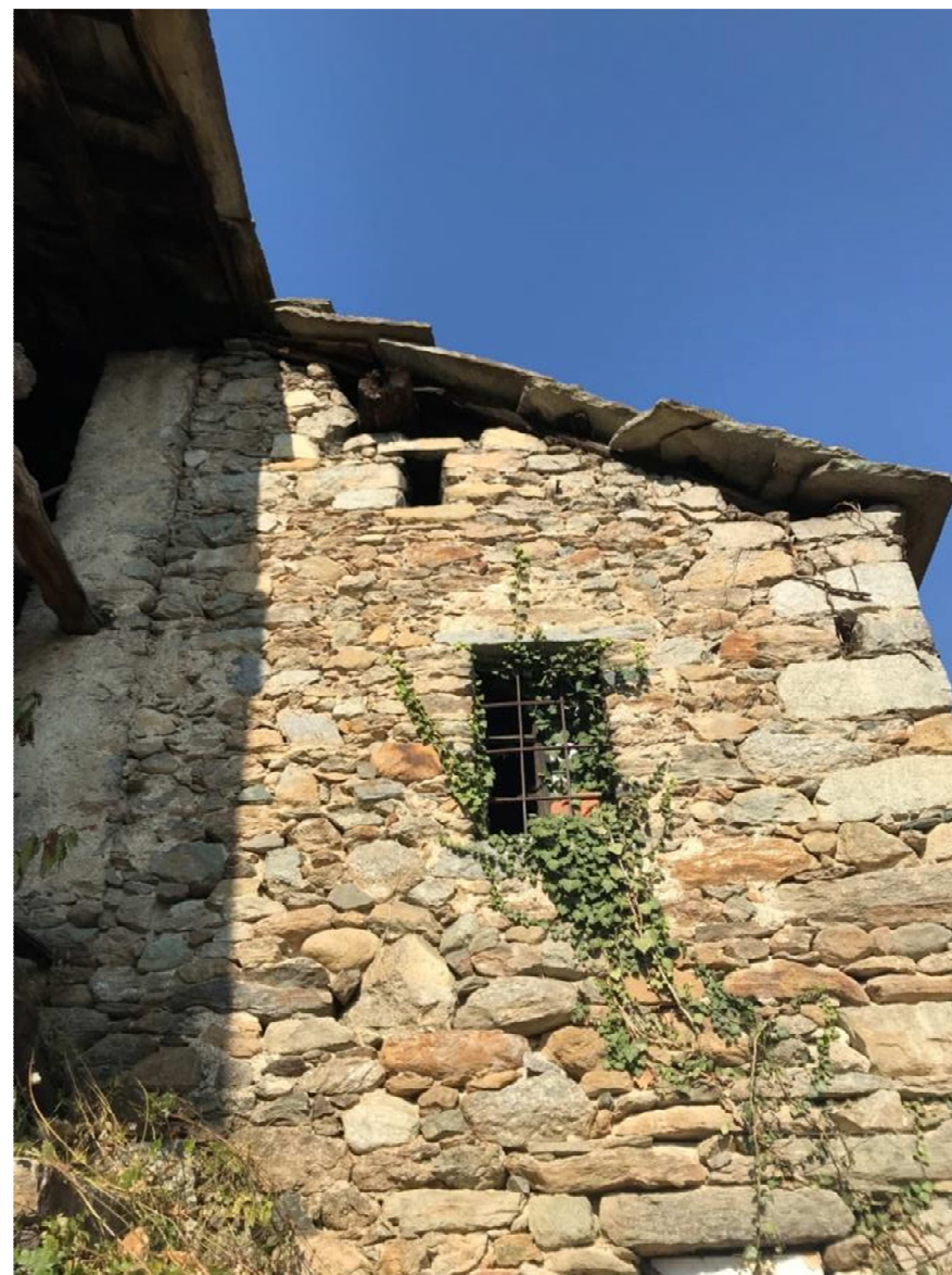
Figura 68: corsi irregolari, posa casuale, collegamento angolare irregolare
