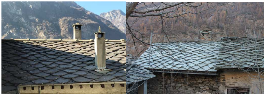
Figura 5: losa a goccia e losa quadrata
