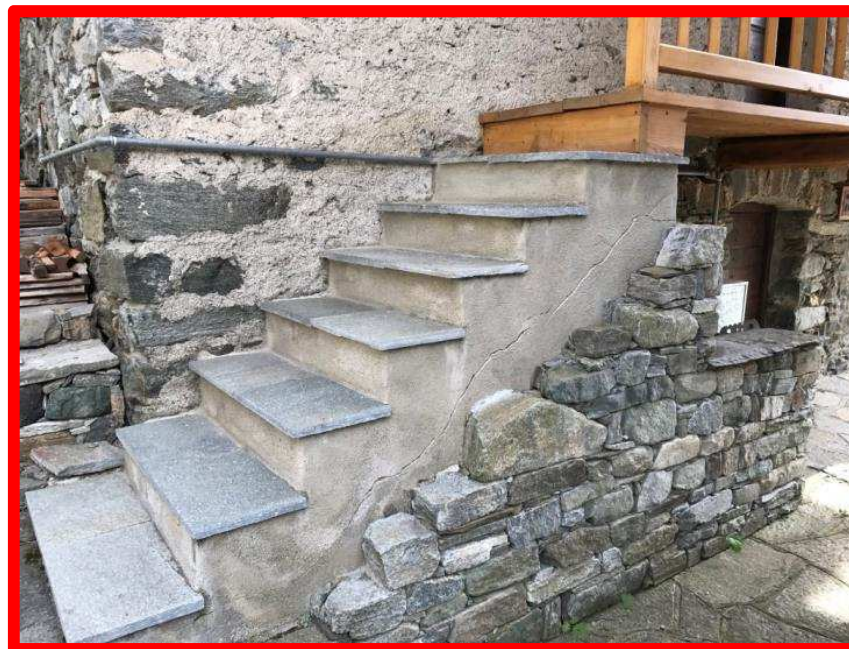
Figura 93: scala in calcestruzzo e pedana lignea
