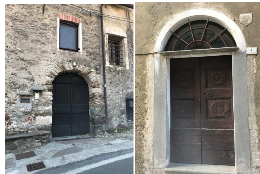
Figura 53 portoni di ingresso in contesto urbano senza e con sopraluce
