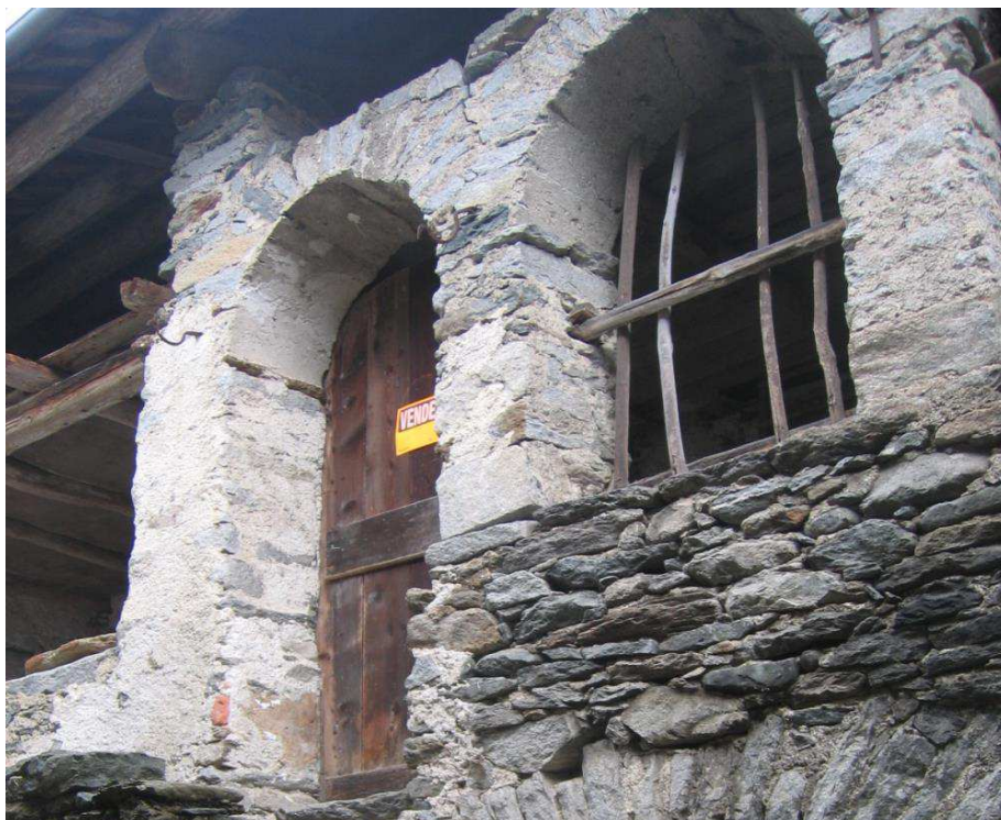
Figura 51 portone di ingresso in ambito rurale
