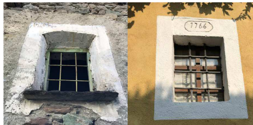
Figura 31 finestra con davanzale e senza davanzale
