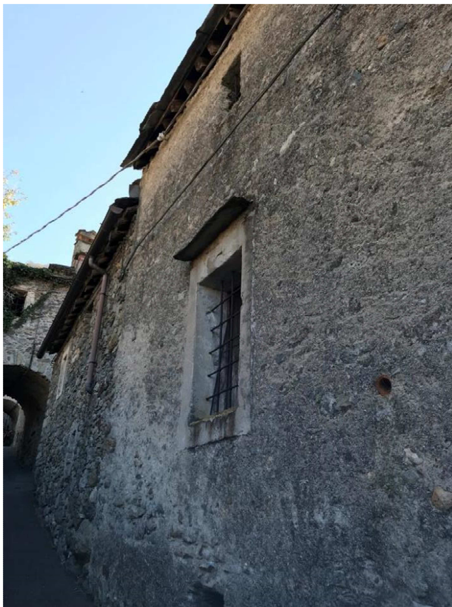
Figura 70 muratura con intonaco raso pietra - Carema
