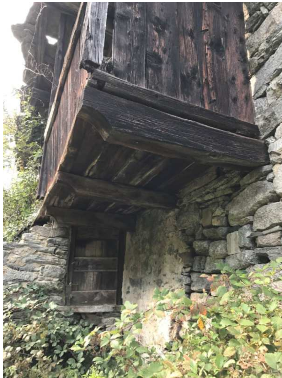
Figura 103: particolare dell'aggancio travi - muratura-ballatoio
