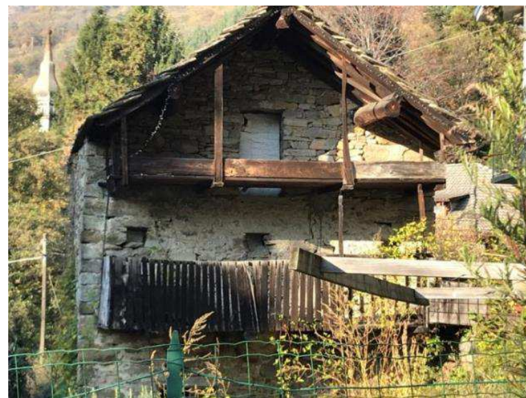
Figura 98: ballatoio all'ultimo piano con un'unica tavola lignea
