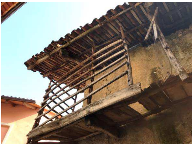
Figura 102: particolare dell'aggancio tetto montanti-ballatoio
