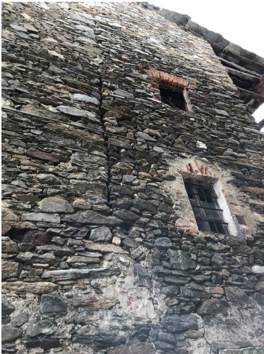
Figura : muratura a corsi irregolari con posa orizzontale - Rueglio
