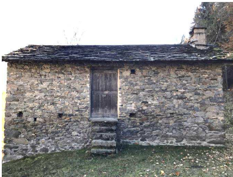
Figura 90: scala in pietra parallela alla facciata principale – Val Soana
