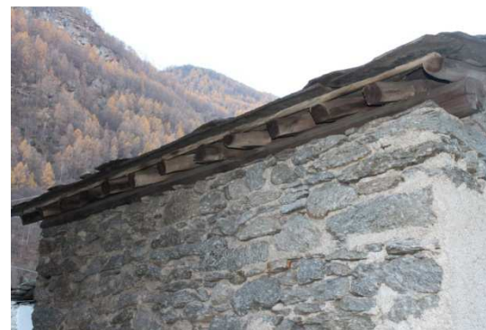
Figura 2: particolare della trave dormiente sul muro perimetrale
