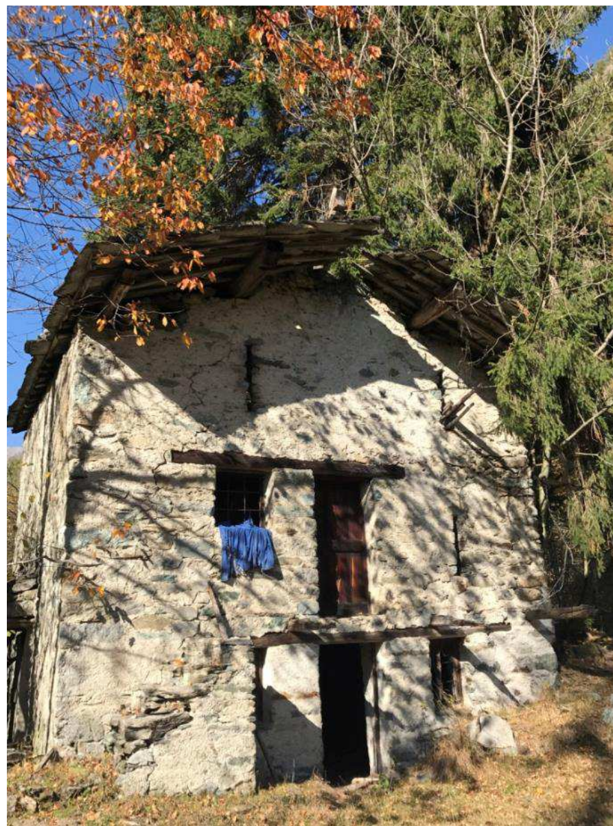
Figura 42: architrave ligneo passante sopra porta e finestre
