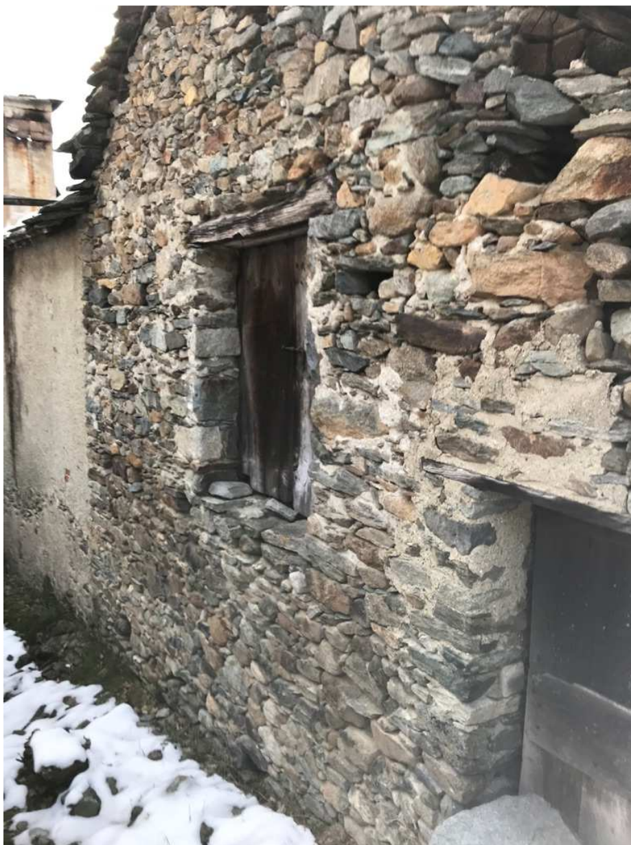
Figura 72: muratura a corsi irregolari con seppe e scaglie in pietra; posa orizzontale - Brosso
