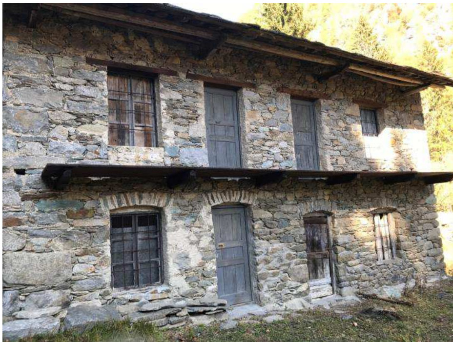
Figura 43: serramenti con architrave ligneo (sopra) e con piattabanda in pietra (sotto)
