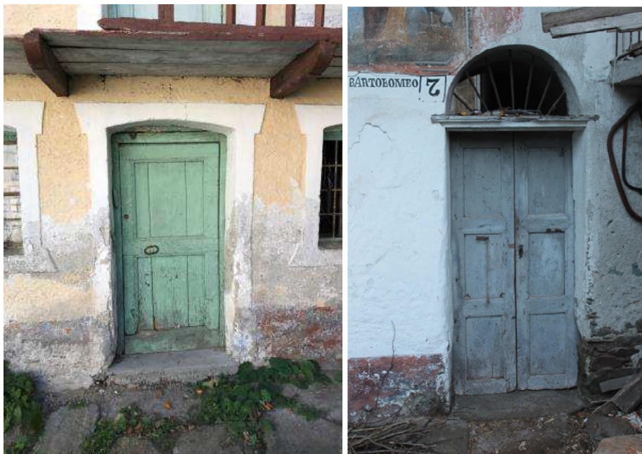
Figura 57 ingresso con fascia intonacata
